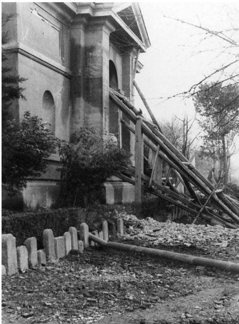
Fig. 12 - Fronte dell'Antiquarium, opere di puntellamento (1940).
