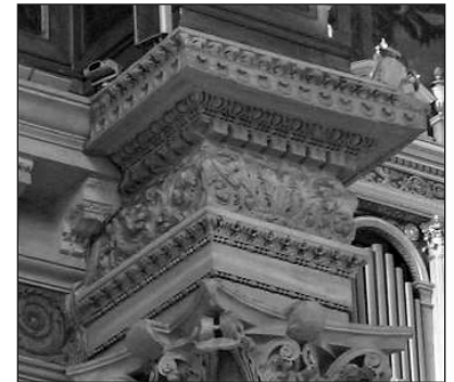
60) Fregio-architrave convesso con decorazione vegetale
