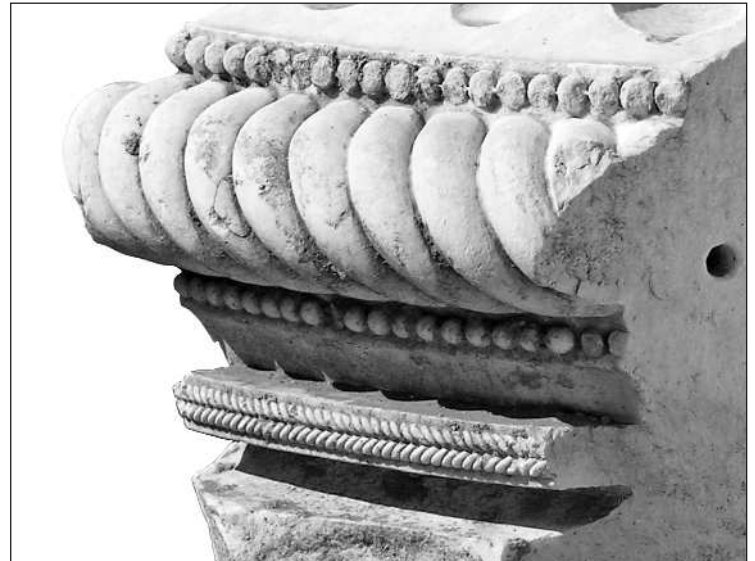
165) Motivo a corda (sul toro superiore e sui due tondini tra le scozie)
